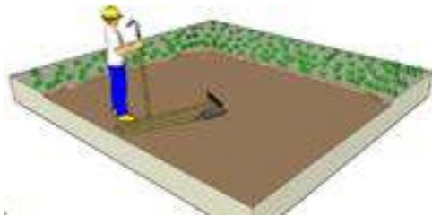
Figura 52. Limpieza y nivelación del terreno
